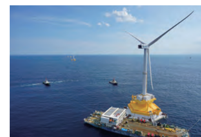
5MWアドバンストスパー型浮体式洋上風車 (福島沖)
