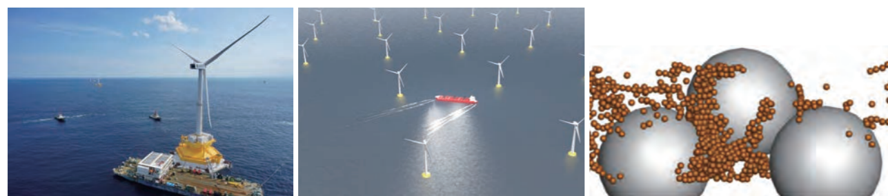
5MWアドバンスドスパー型浮体式洋上風車 (福島沖)
