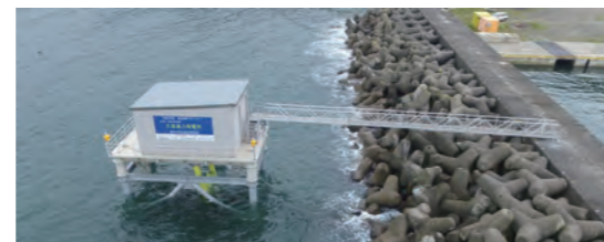
岩手県久慈市の波力発電システム(定格出力43kW) Wave Power Generator (43kW) to be installed at Kuji City, Iwate Prefecture
