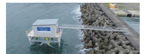
岩手県久慈市の波力発電システム(定格出力43kW) Wave Power Generator (43kW) to be installed at Kuji City, Iwate Prefecture
