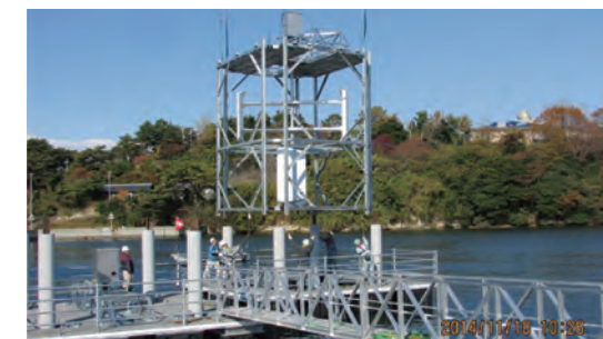
宮城県塩竈市寒風沢水道の潮流発電システム(定格出力5kW) Tidal Current Power Plant (5kW) installed at Sabusawa channel in Shiogama City, Miyagi Prefecture
